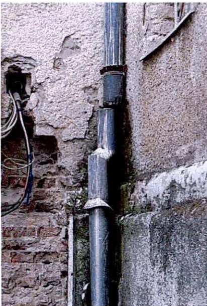
A képeken az ázás következménye látható a 14. épület ugyanazon falazakaszán kívülről és belülről.
