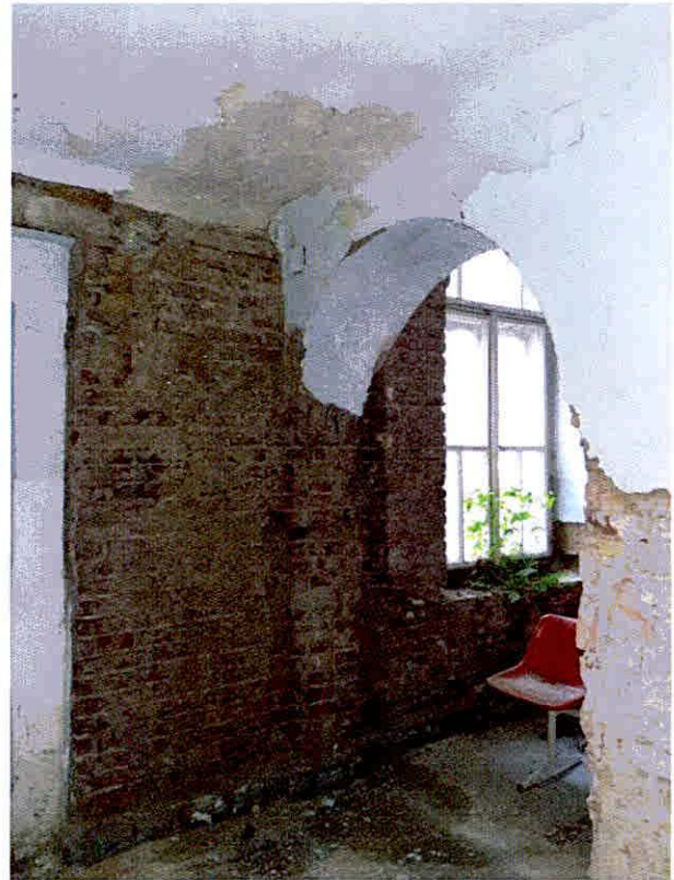
A képeken az ázás következménye látható a 14. épület ugyanazon falazakaszán kívülről és belülről.
