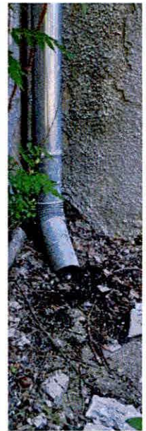
A képeken az ázás következménye látható a 14. épület ugyanazon falazakaszán kívülről és belülről.
