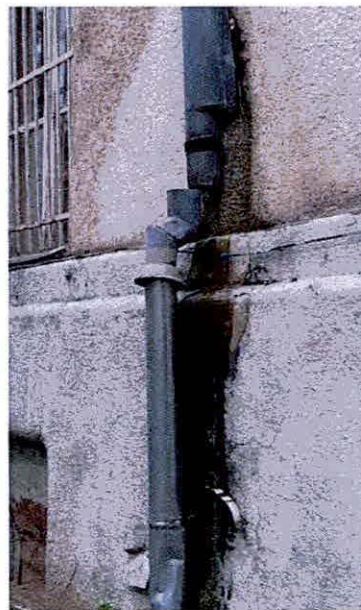
A képeken az ázás következménye látható a 14. épület ugyanazon falazakaszán kívülről és belülről.
