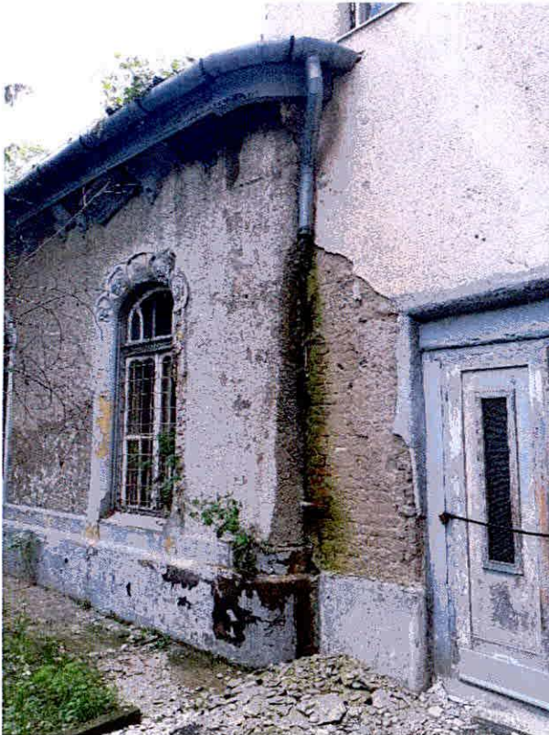
A képeken az ázás következménye látható a 14. épület ugyanazon falazakaszán kívülről és belülről.
