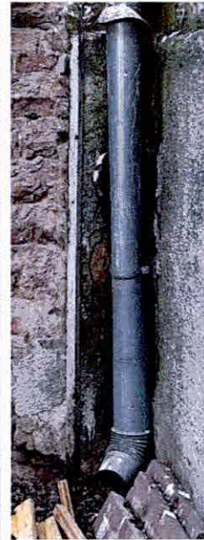
A képeken az ázás következménye látható a 14. épület ugyanazon falazakaszán kívülről és belülről.
