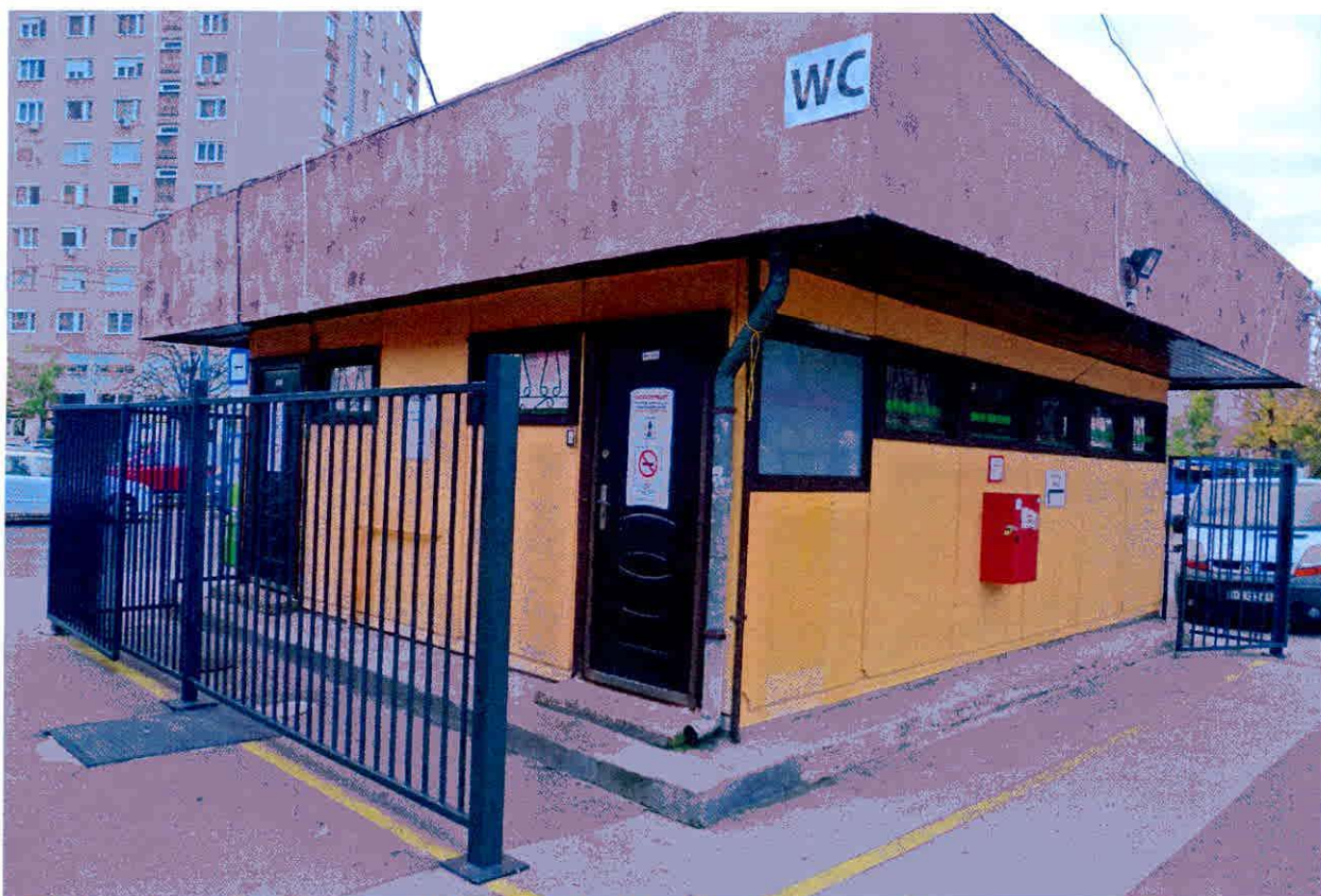
Felújítás után: a régi-új kereskedői WC a Páskomliget-Kontyfa utca sarkán
