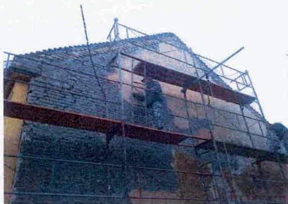
8. kép; Vakolatleverés, gúzolás, újvakolás
