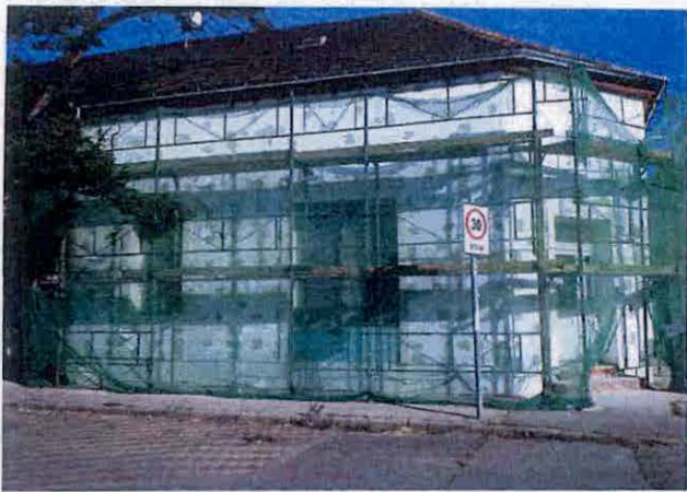
5. kép; Kész falszigetelés dübeles rögzítéssel
