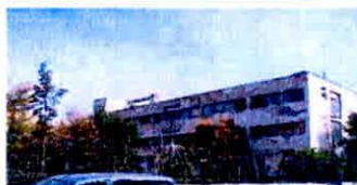
3. kép: Az egykori nővérszálló épülete
