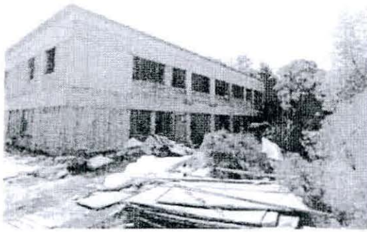
1. kép É-i homlokzat
