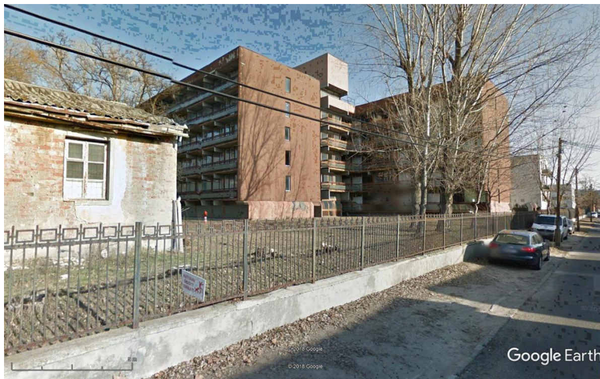
11. ábra: A 33-as épület dél-nyugati homlokzat
