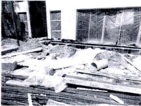
85. kép D-i homlokzat előtti tér
