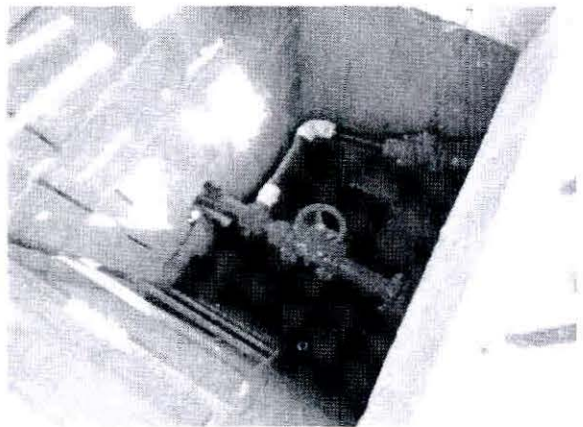
96. kép víz főelzáró aknája
