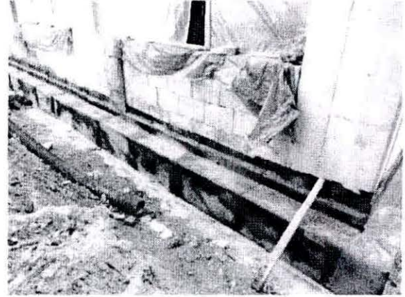
30. kép Nem megfelelő a szigetelés felvezetési magassága
