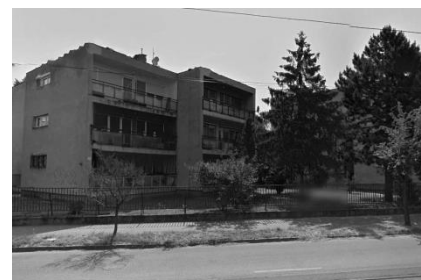
1970-1972 Bánkút utcai társasházi telep 105 lakás
