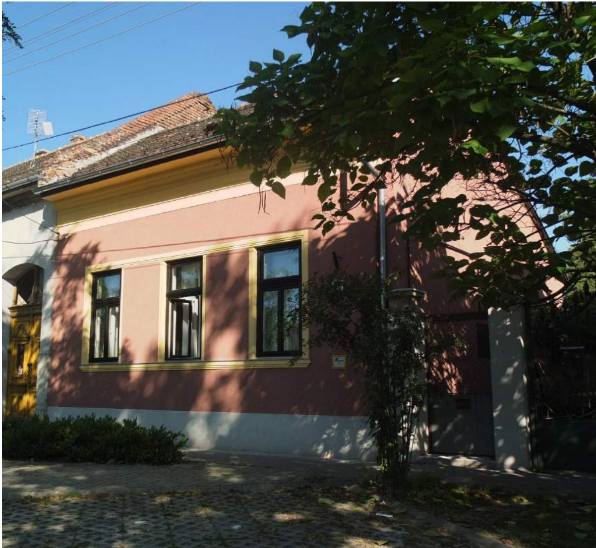
A meglévő épület hőszigetelése után az eredeti vakolatdísz és színezés került visszaállításra.
