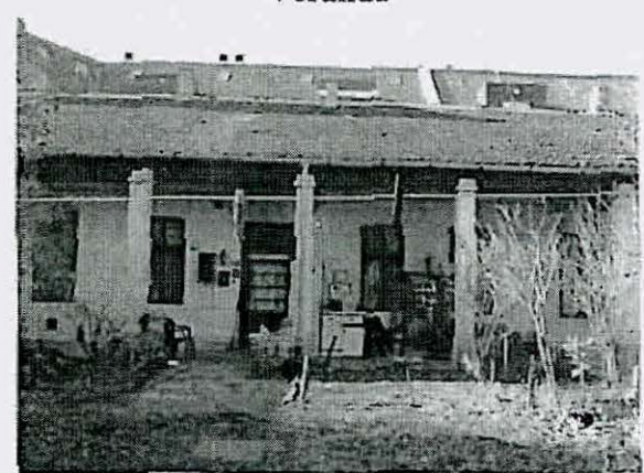
Belső udvari homlokzat
