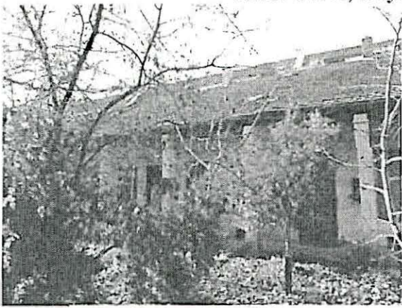
Belső udvari homlokzat
