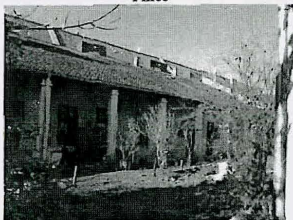
Belső udvari homlokzat
