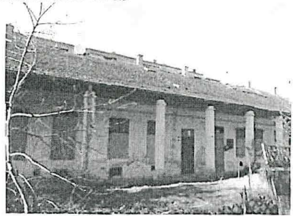
Belső udvari homlokzat
