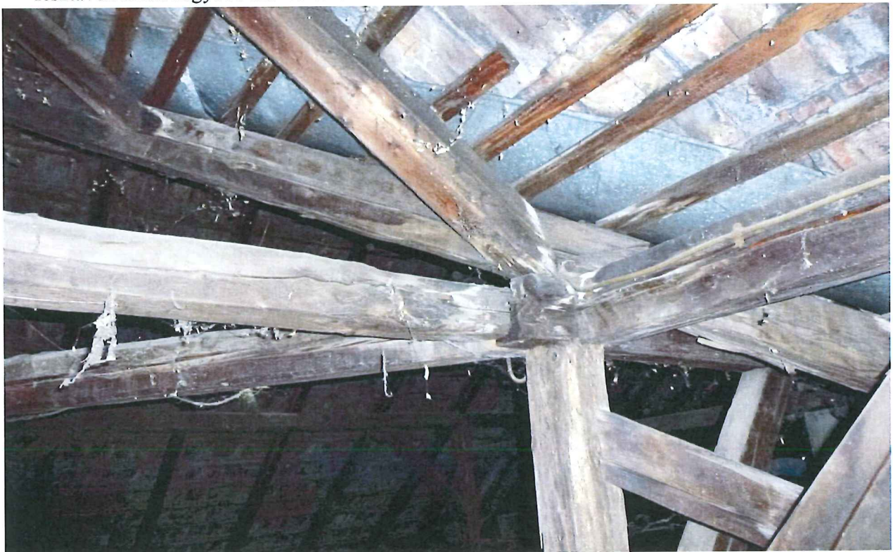
Udvari sarok rész a vápa bádogozással és faanyagokon lévő elszíneződésekkel.
