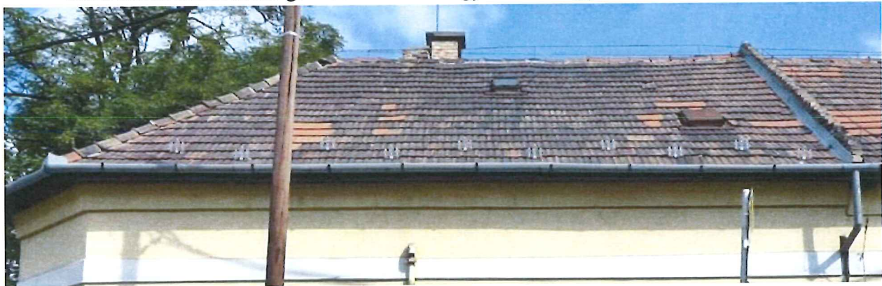
A cserepezés sok helyen kisebb foltokban cserélve, átrakva volt. A lécezés és szarufák lehajlásai miatt a cserepezés nem tud egyenletesen elhelyezkedni és folyamatosan felfeküdni. Ez a beázás esélyét fokozza.
