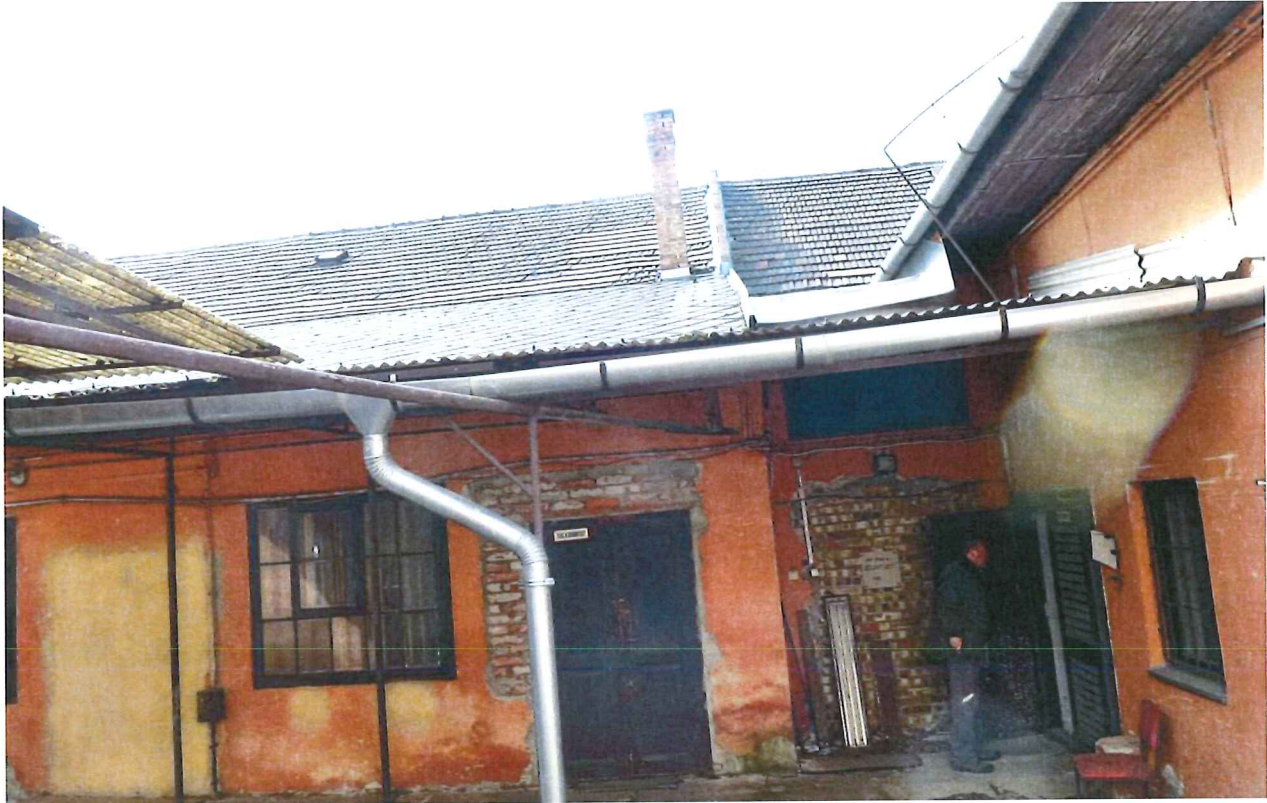
Az udvaron több alacsony hajlású, lábakon álló, üvegszálás hullámlemezrel fedett előtető került kialakításra.
