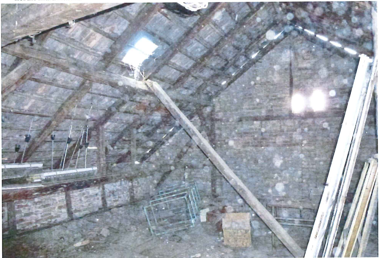
Tetőszerkezet utcai oldal. Süllyesztett kialakítású tetőszerkezet.
