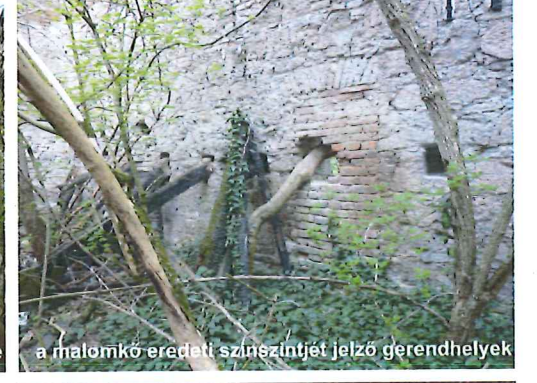
Szilas patak felőli homlokzat belső nézete
