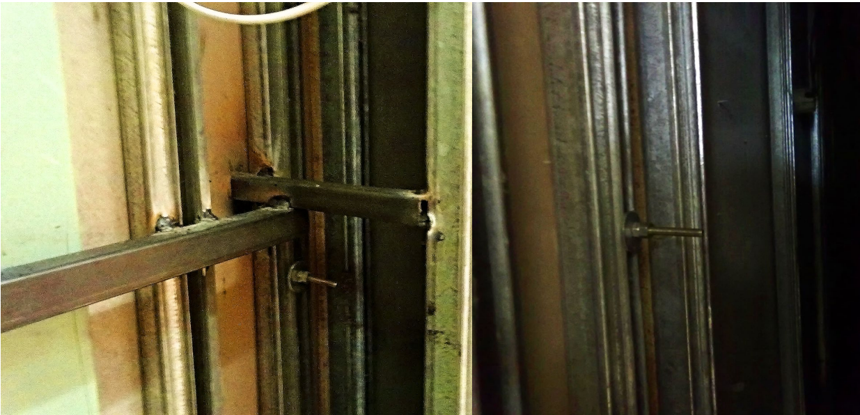
Kapaszkodó rögzítés és megerősítés
