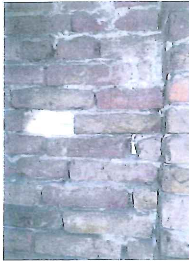
Meglévő tűzfal állapota a tetőtérben
