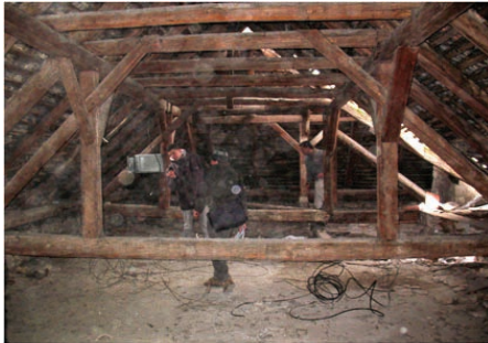
Kétállószerűes, kötőgerendás tetőszerkezet
