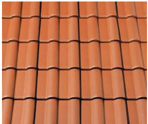
Egyszeres sajtoltszerű cserépfedés
