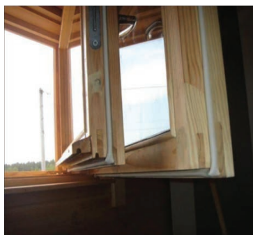
2. Tok-szárny kapcsolat tömítése gumiprofilal
