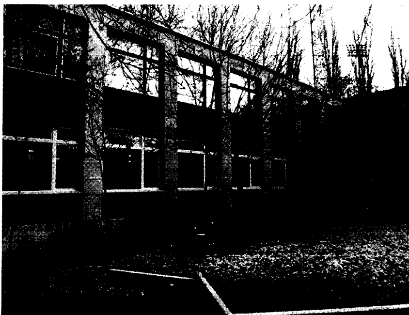
1. az észak-nyugati szárny dél-nyugati homlokzata
