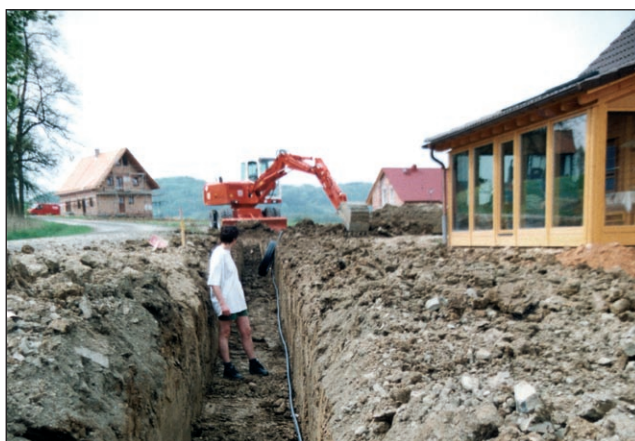
6. ábra. Vízszintes elhelyezés, árokásásos módszerrel
