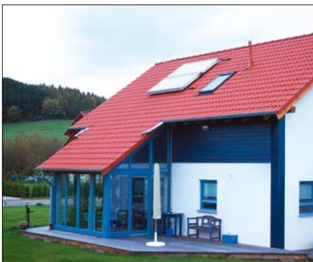
1. kép Tetőre szerelt napkollektor
