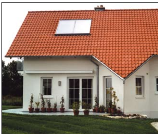
2. kép Tetőbe szerelt napkollektor
